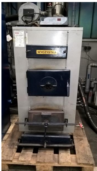
Rys. 2. Widok kotła c.o. typu GENERATOR o mocy 35 kW
